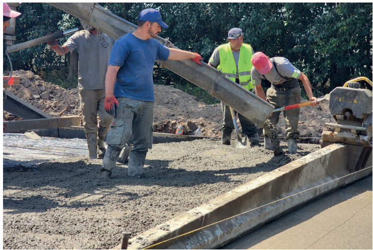
En algunos sectores ya están terminados los trabajos (Pág. 4)
