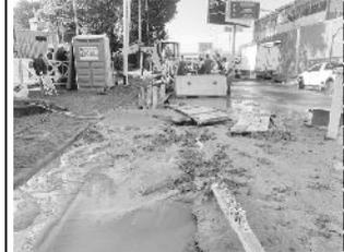
En Avellaneda, AySA finalizó, luego de varias horas de trabajo durante la madrugada, la reparación de una importante cañería maestra de 500mm de diámetro. La rotura fue producida por una empresa que estaba trabajando para la instalación de tendidos eléctricos de alta presión. El incidente ocurrió en la Avenida Debenedetti y la calle Iguazú, de Crucecita.
