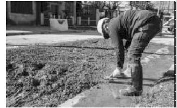
Los equipos técnicos destacaron el buen ritmo de trabajo y contaron cómo es el procedimiento. Primero, se demuele la superficie en mal estado. Seguidamente, se limpia y se compacta la base con tosca para reponer el nivel. Luego, se realiza el bacheo en hormigón pobre y tipo H30 con base de polietileno. Y, finalmente, se hace el tomado de juntas con emulsión asfáltica para evitar futuras filtraciones y reforzar, así, la vida útil de la calle.
