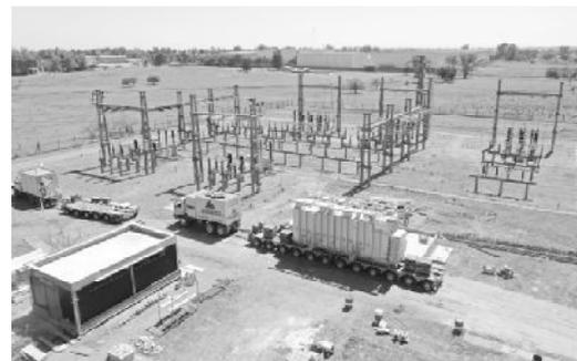
La Subestación Bosques es una pieza central para la distribución de electricidad en zona sur, ya que integra un corredor junto a la Subestación Dock Sud que alimenta otras 9 Subestaciones. Con la instalación del nuevo transformador, ahora el centro de transformación cuenta ahora con una potencia total de 900 KVA.
