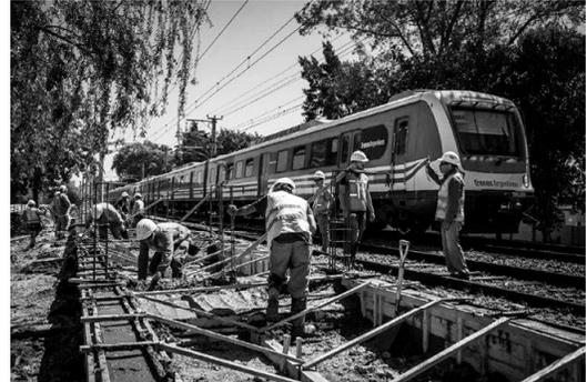
que durante las últimas semanas se realizó el volcado de hormigón desde avenida Centenario. Además, se llevaron a cabo tareas en relación al andén con el hormigonado de sus bases y su rampa de acceso con el ejecutado de tabiques de contención para la nivelación del mismo.
