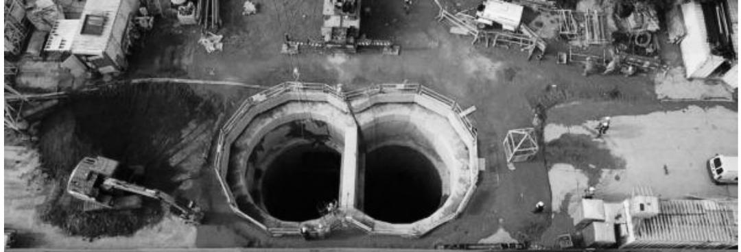
**AySA trabaja activamente en las obras del Sistema Agua Sur, alcanzando un nuevo hito con la construcción de la Estación Elevadora N° 1 en Lomas de Zamora, que impulsará el caudal proveniente de la Planta Potabilizadora General Belgrano hacia las redes primarias que forman parte del sistema.**
